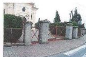
641. Wierzchucin K. mur kośc.
