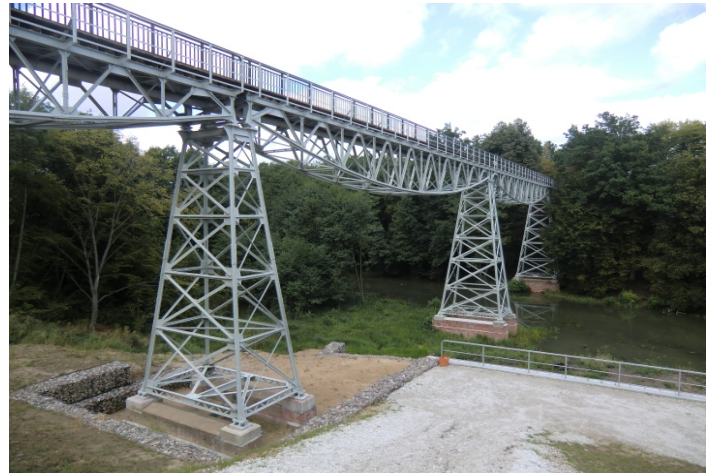
22. Koronowo - most kolejki wąskotorowej nad rzeką Brdą
